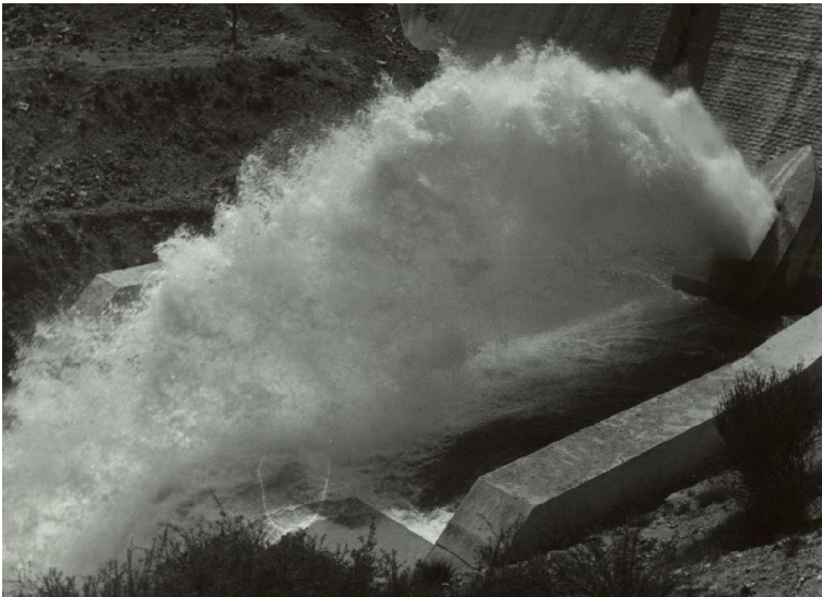
1962 - L'apertura dello scarico di fondo della Diga (Foto Archivio Consorzio Bonificazione Umbra)
